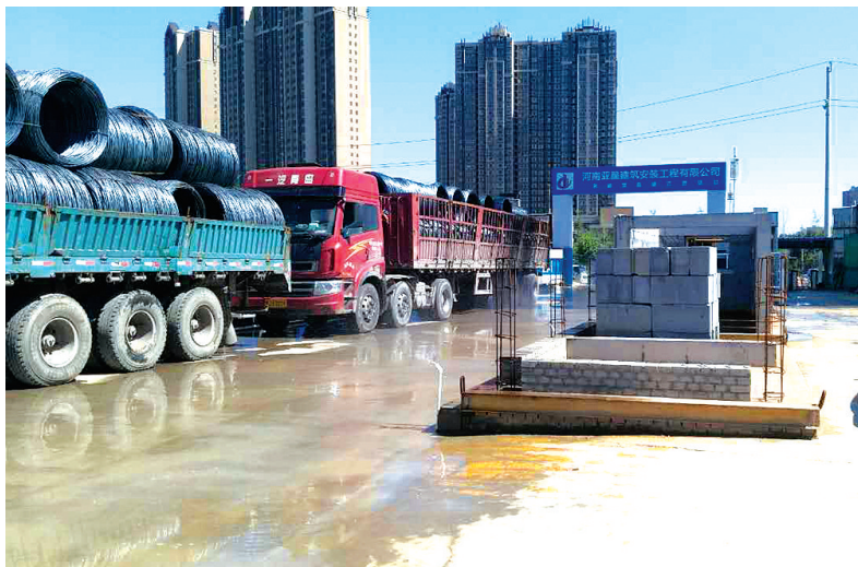
建筑工地对车辆进行喷水
