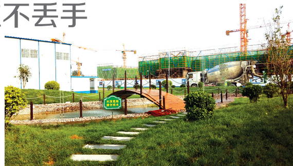
张寨安置房一标段建筑工地
