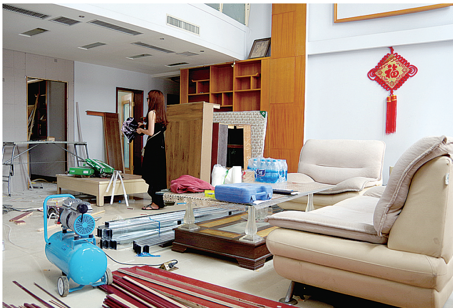
毛女士租下的复式房客厅正在进行分隔装修
