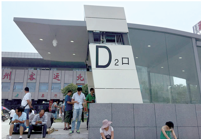
地铁2号线刘庄站出站口
