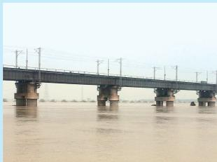
1958年,一座中国自行设计的铁路大桥,在位于“一桥”下游500米处破土动工。这就是“二桥”,全长2889.8米,72个桥墩。从动工到1960年4月25日正式通车,只用了不到两年的时间。
