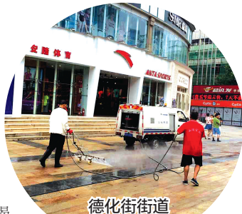
德化街街道清洗商业街路面
