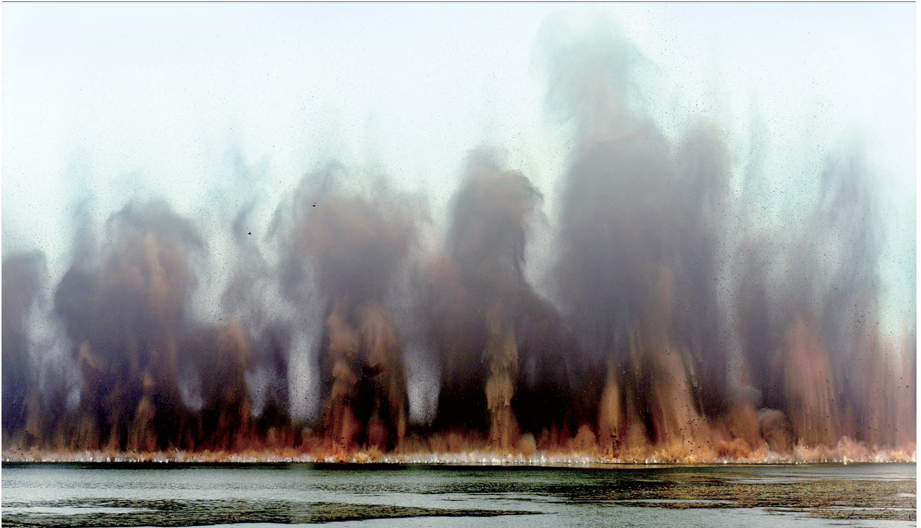
7月14日,梁子湖与牛山湖隔堤在实施爆破作业。
