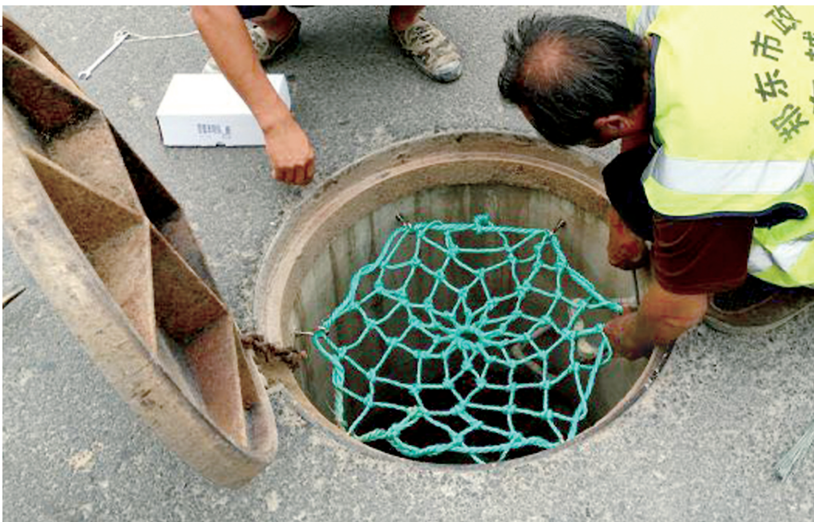
市政施工人员在为郑东新区龙湖区域雨污水井加装防坠网 郑州晚报记者 马燕 图
