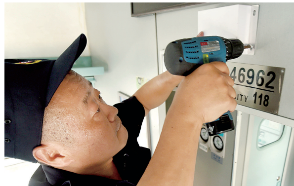
昨日,郑州铁路局工作人员在车厢安装WiFi设备。新华社发
