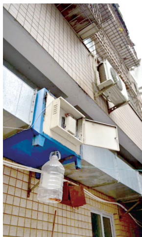
油烟净化器下边的塑料瓶用来防止滴水
