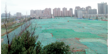
对裸露土地进行覆盖
