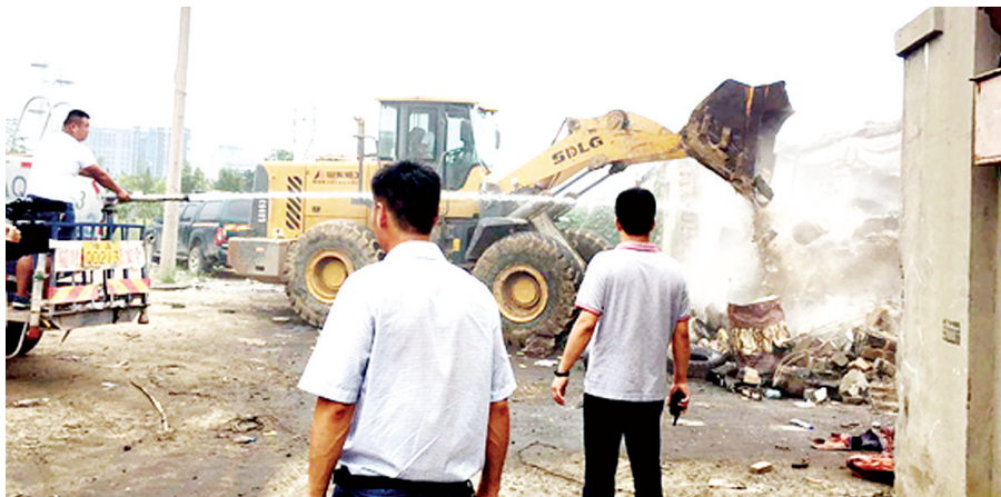
治理污染现场
