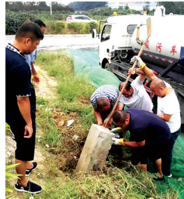
维修师傅们正在改造下水道
