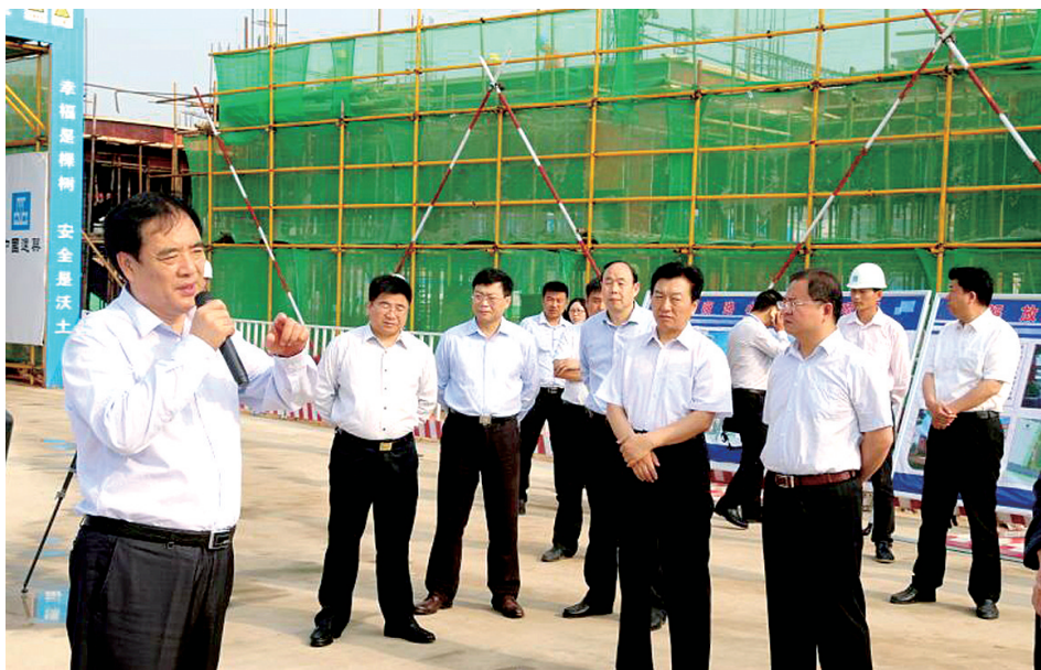
樊福太到新建学校施工现场视察工作
