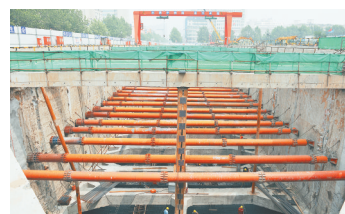
地铁2号线土建施工现场 资料图片
