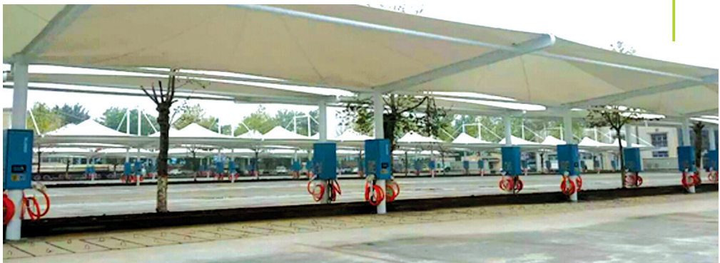
天迈承建的充电运营管理平台及场站
