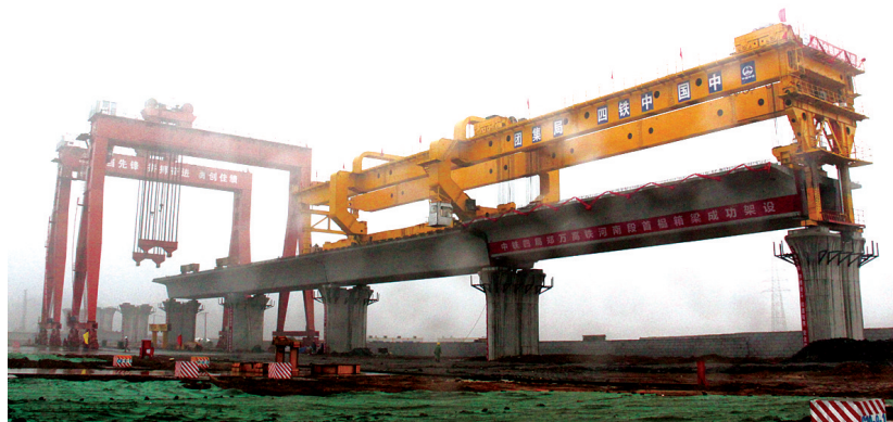
郑万铁路河南段首孔箱梁成功架设
