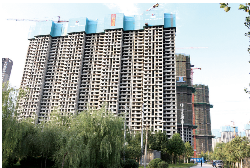
南仗村正在建设中的安置房
