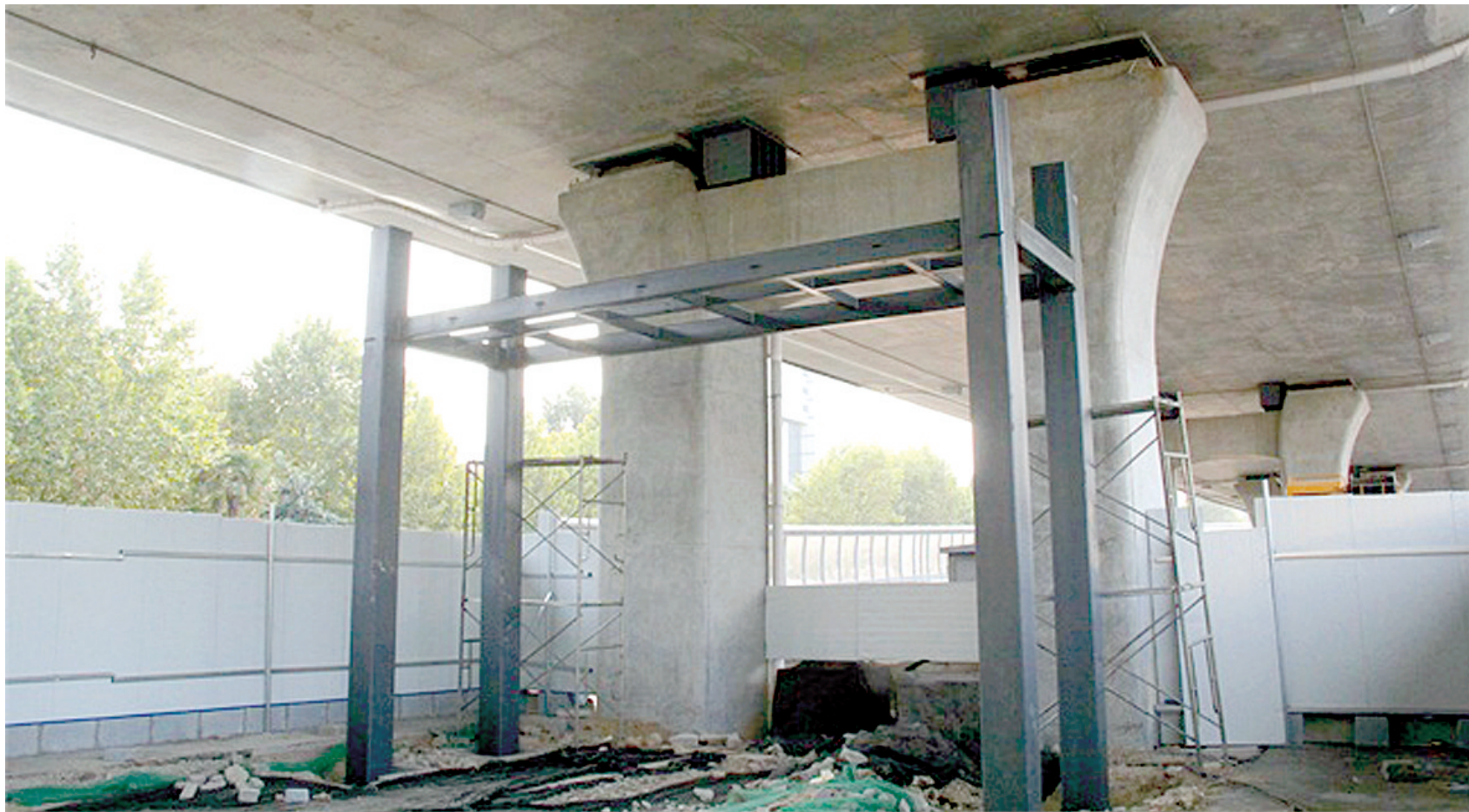
一些BRT公交站台已开始建设安装
