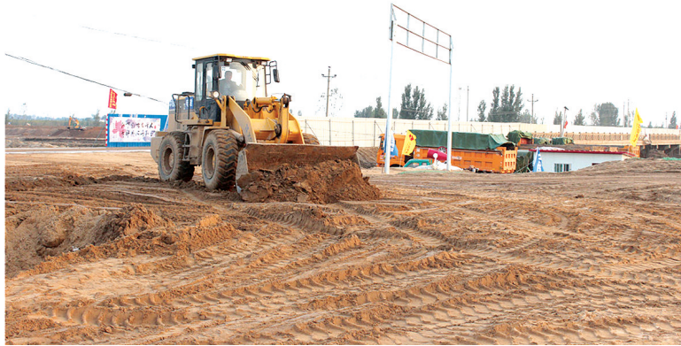
贾鲁河生态治理工程现场
