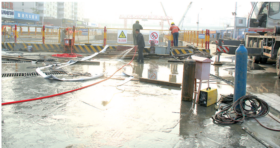
地铁5号线土建施工O1标工地,工作人员在洒水。
