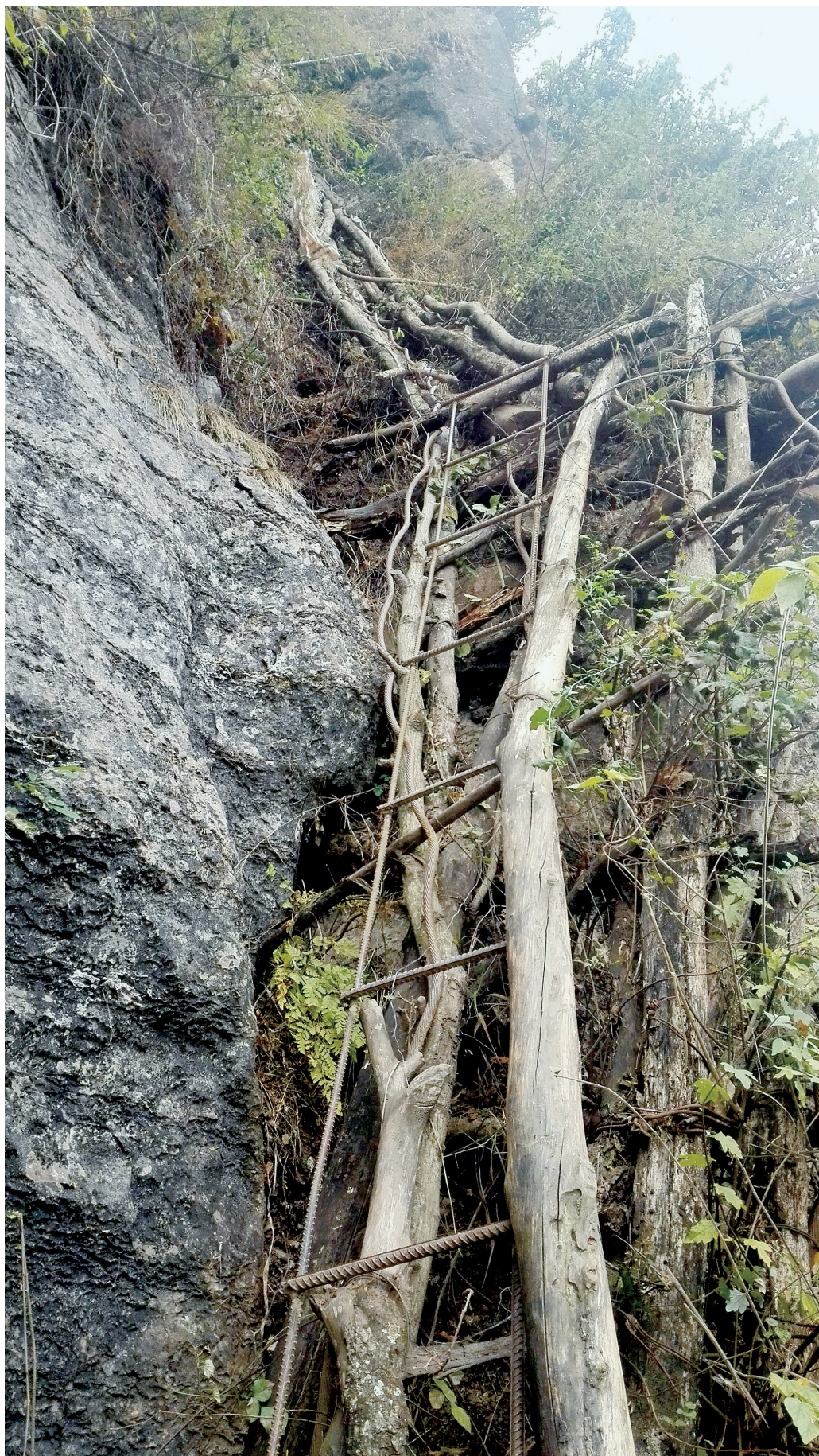
阿土列尔村民常用的藤梯,一些木头腐朽了 郑报融媒记者 石闯 图
