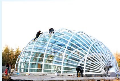
正在修建的龙子湖地铁站台
