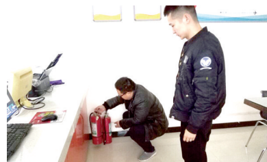
排查消防设施安全
