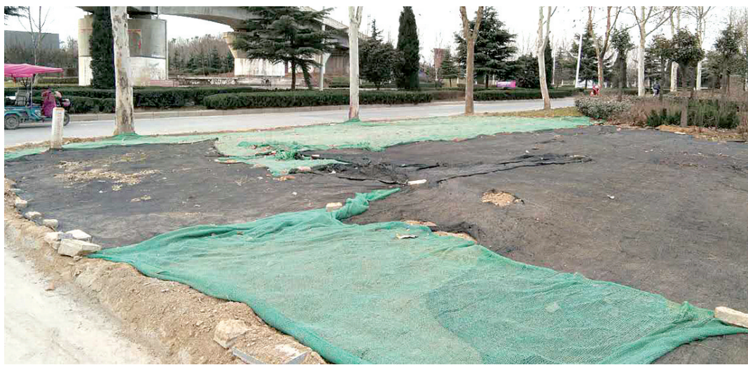
区绿化所将未清理到位的地面覆盖防尘网
