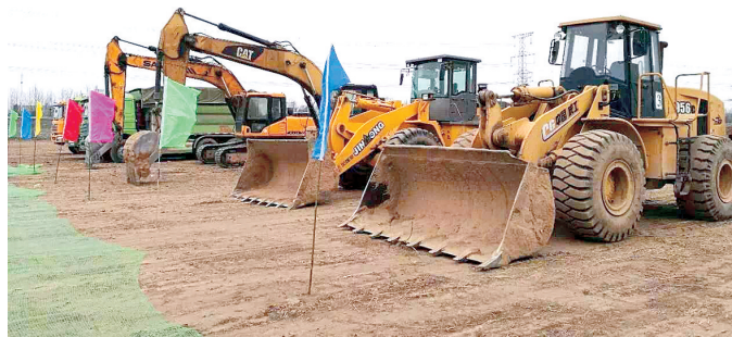
开工现场挖土机等工具已准备就绪
