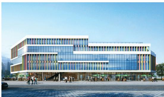
永平路便民服务中心项目位于郑东新区中州大道与永平路交叉口东北角，总建筑面积为11702.77平方米；地下2层，建筑面积为4813.86平方米；地上4层，建筑面积为6888.9平方米，建筑总高度为16.10米，总投资为1.3361亿元。主体施工单位为河南胜达建筑工程有限公司，监理单位为河南省海虹建设监理工程有限公司。目前工程进度为主体正在施工，自来水、正式电的施工作业。
