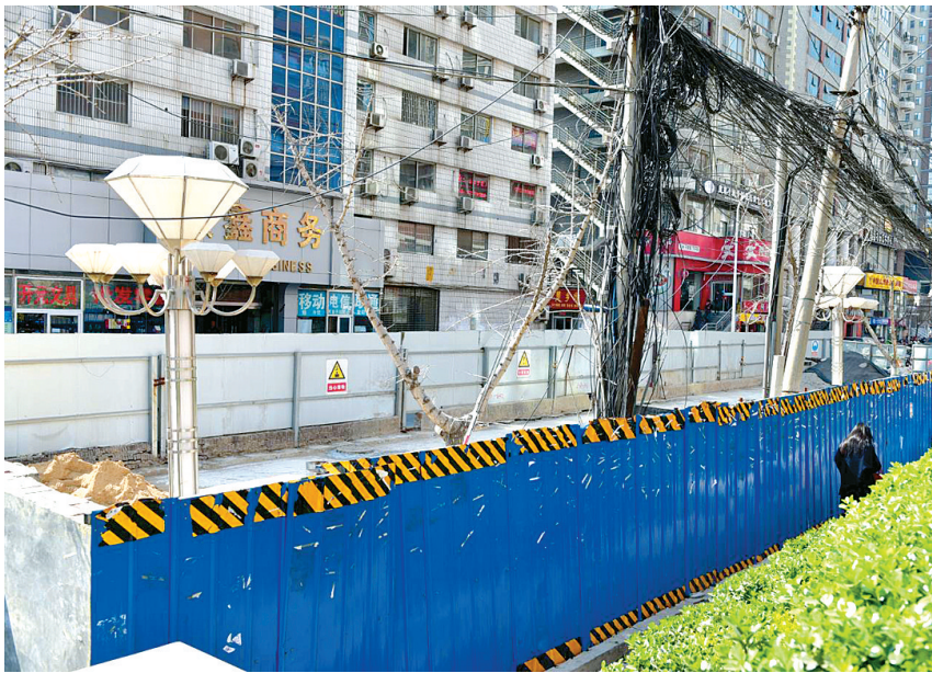
围挡占据了一半农科路
