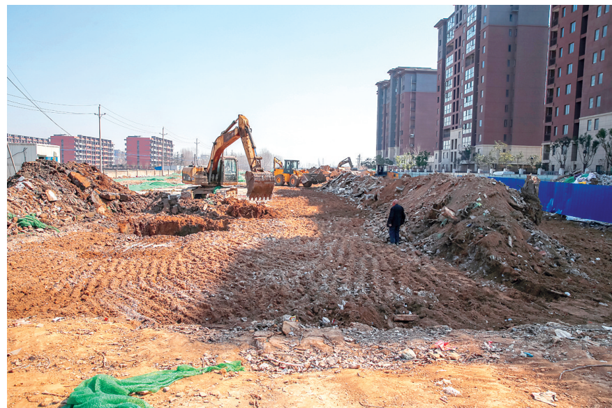
已经开工建设的滨河路(中州大道—文化北路)
