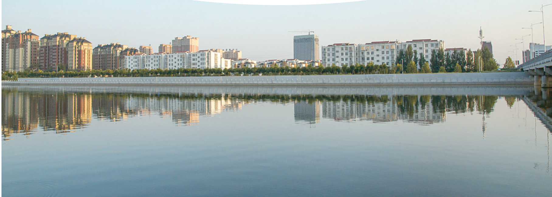
中牟境内贾鲁河现貌
