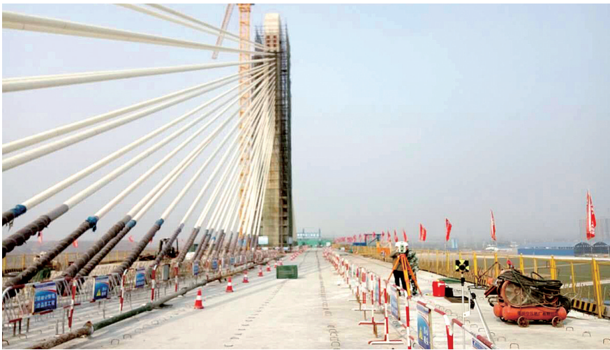
商登高速施工现场
