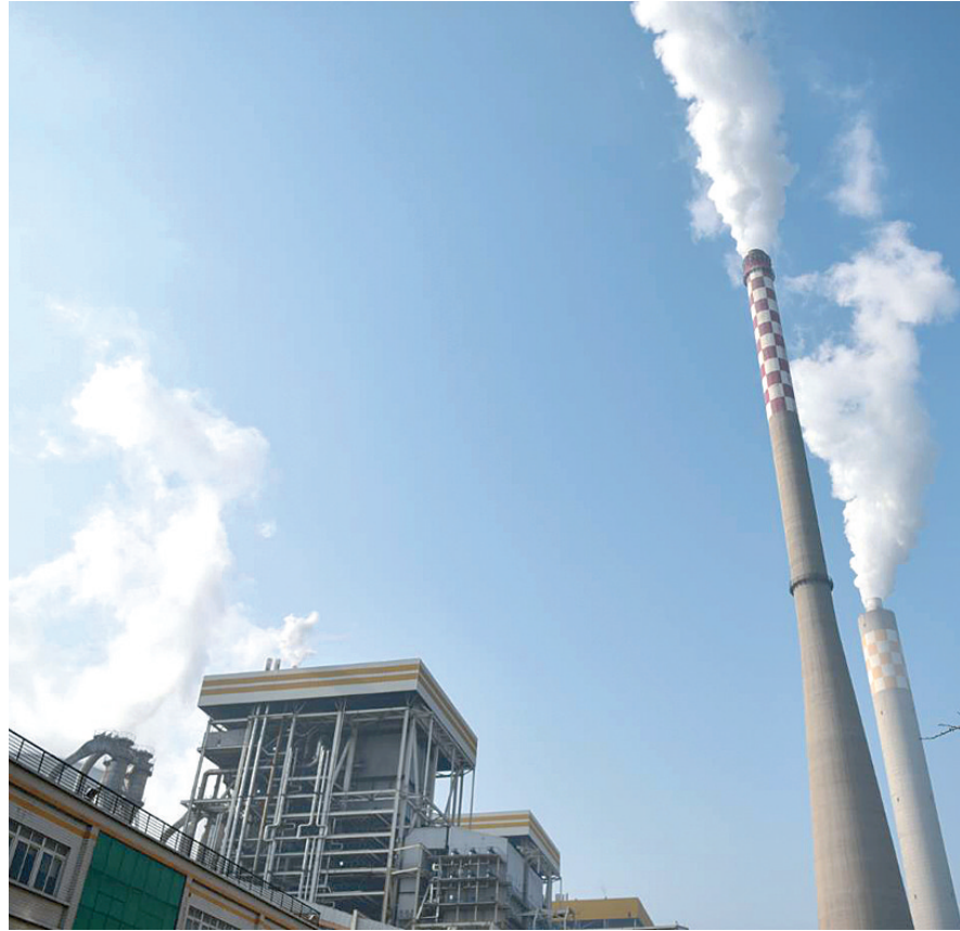
治理后的电厂实现超低排放
