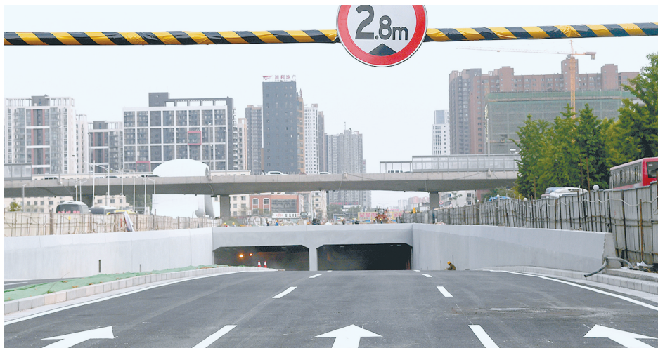
现场 隧道今早放行,暂限小车通行
