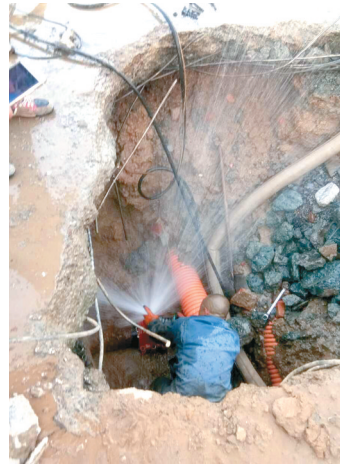
工人抢修巡线员查出的漏点
