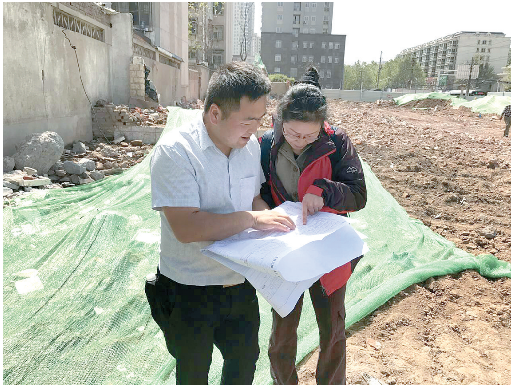
巡线员在重点工地,与施工人员沟通
