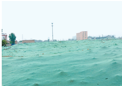
工地防尘网覆盖到位
