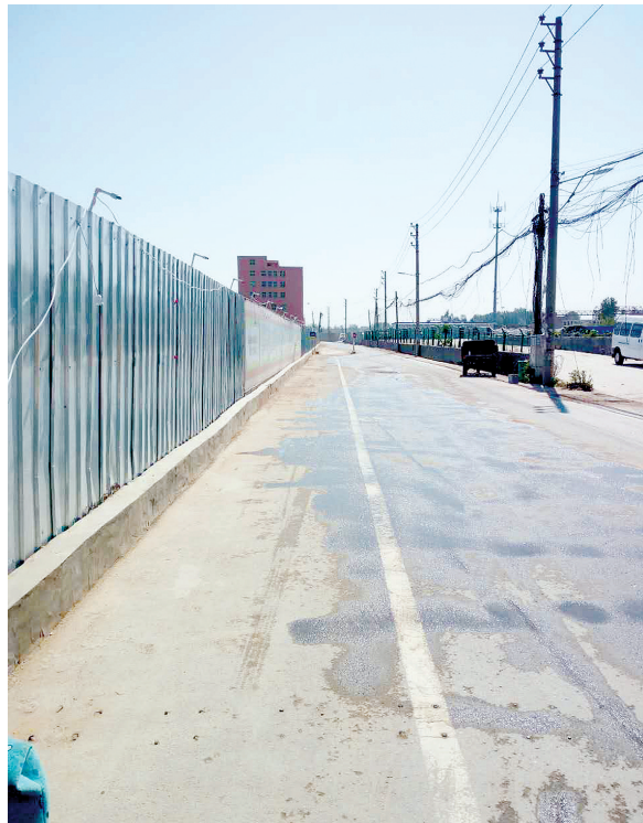
建筑工地围挡加装基座
