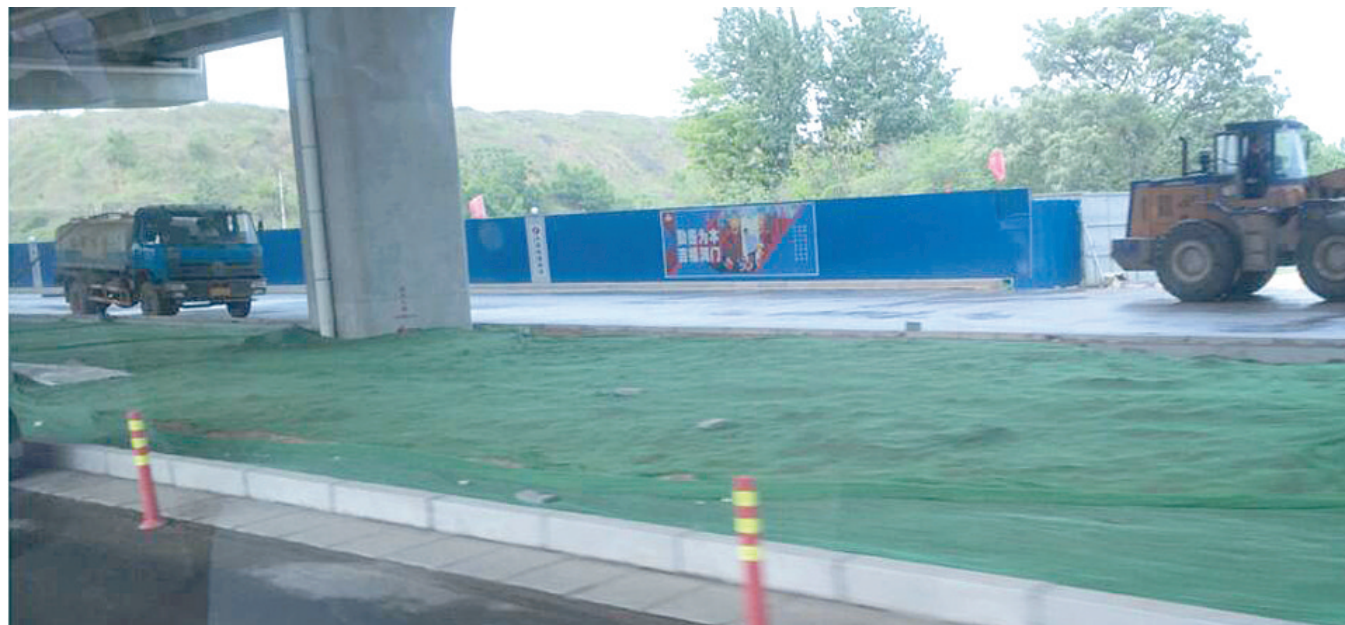
东三环中间隔离带还没正式绿化,施工方除了覆盖防尘网,还播撒草籽
