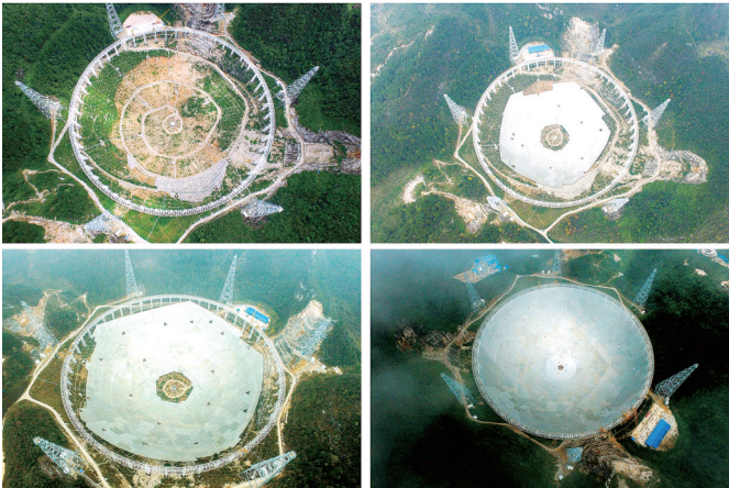
FAST项目从安装第一块反射面板到即将完成的过程
