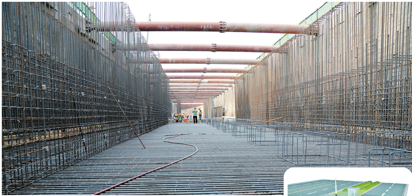
白沙园区综合管廊施工现场
