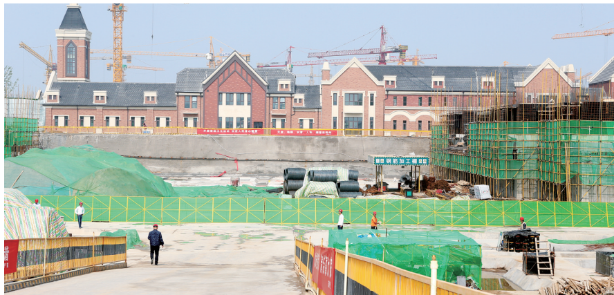
贾河安置区项目
