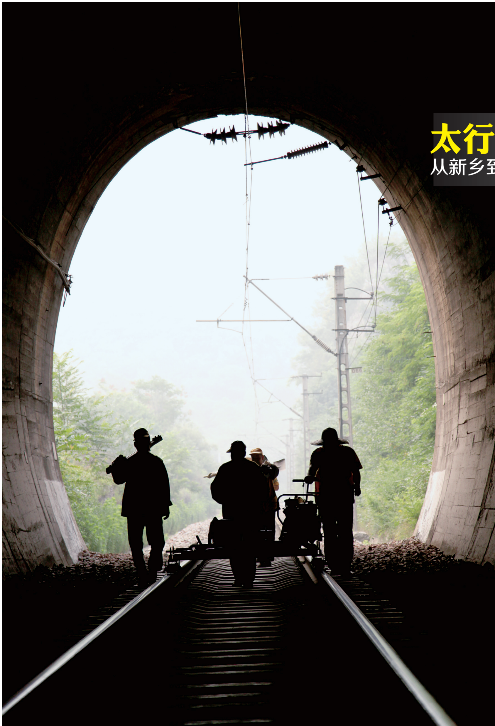
慢火车要经过很多隧道
