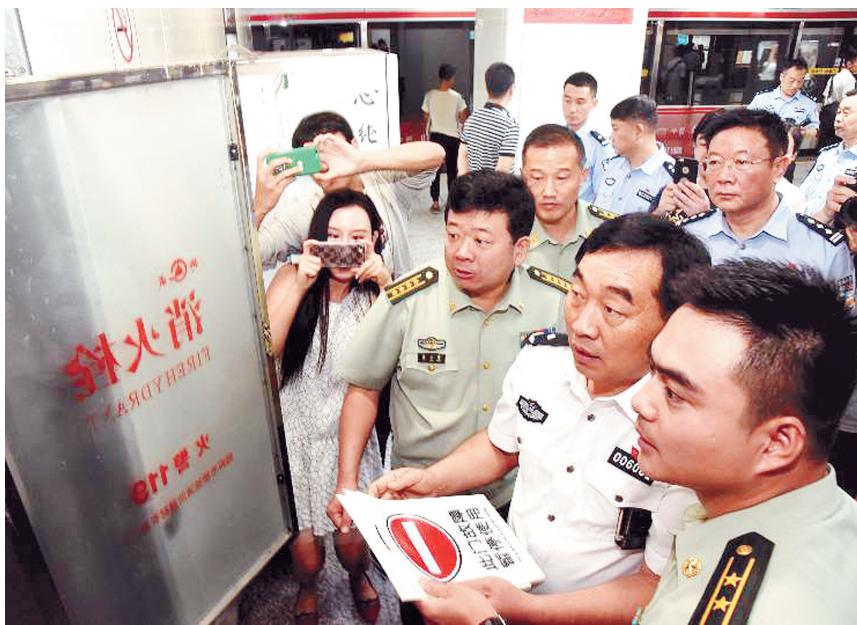
检查地铁消防设施
