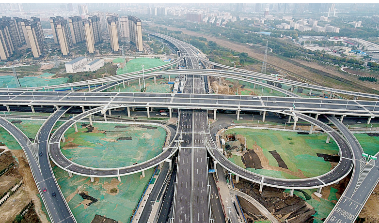
北三环东三环互通式立交桥
