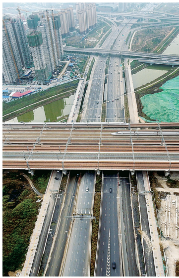
下穿京广高铁的北三环快速路
