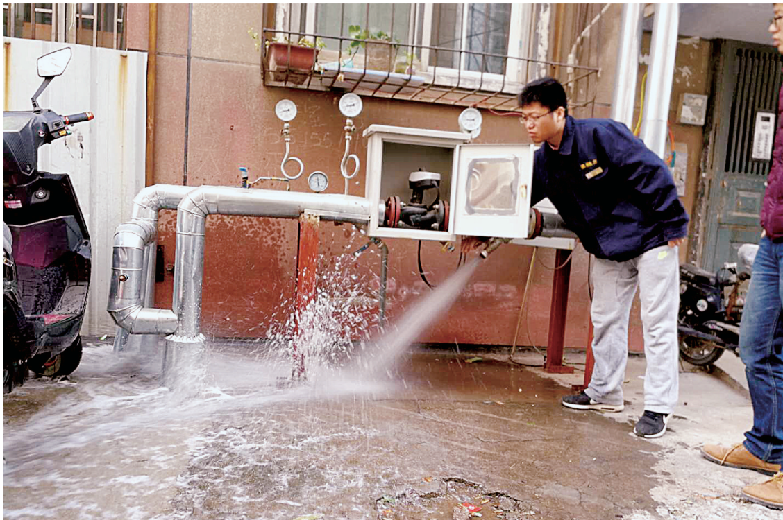
六冶家属院南区今年改造后首次供暖,一个单元不热,工作人员放水调压找原因
