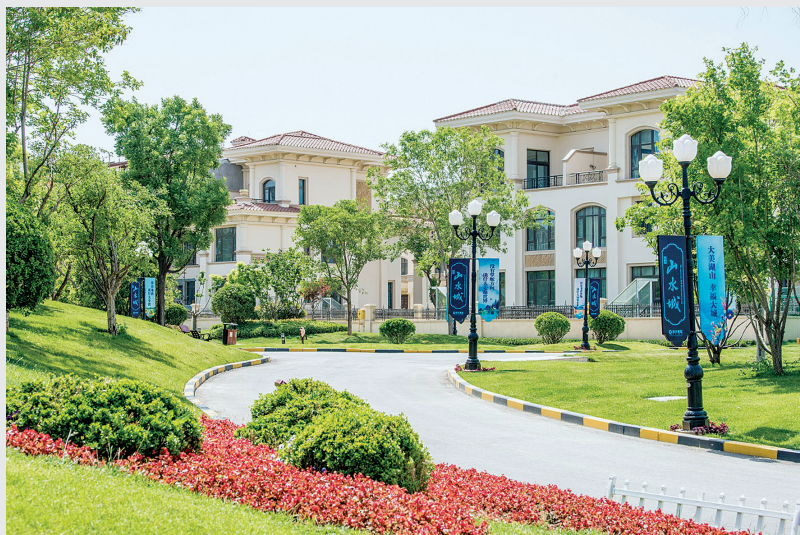
恒大山水城园区实景图
