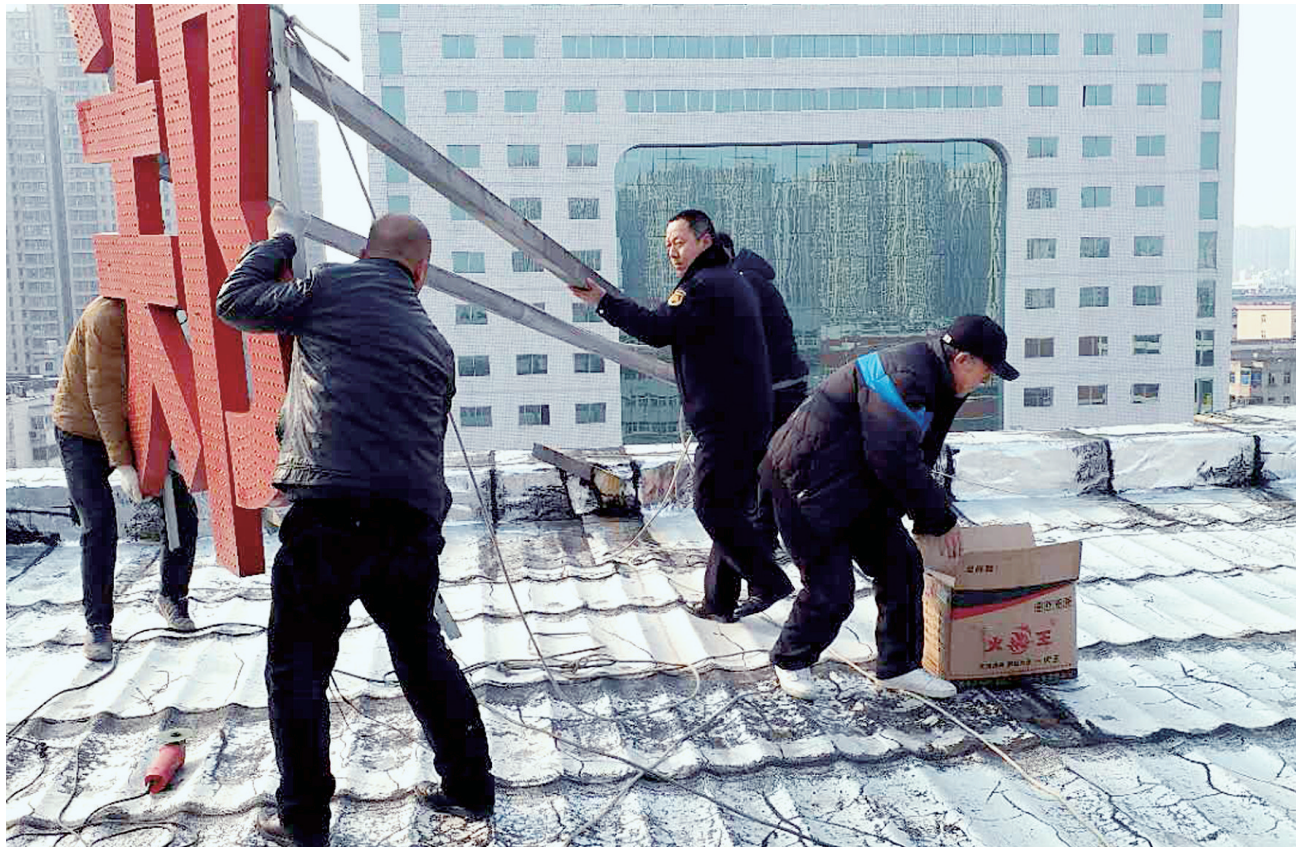
市园林局楼顶“招牌”拆除现场
