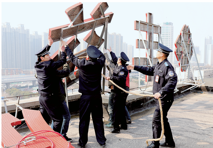
执法人员拆除嵩山路陇海路口一处违规楼顶广告
