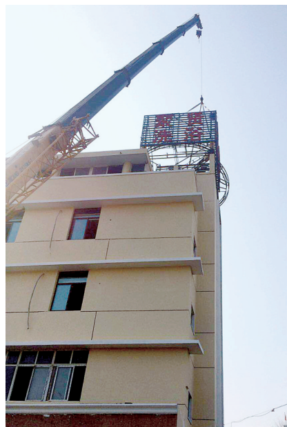
经开区拆除经北一路某洗浴中心楼顶招牌
