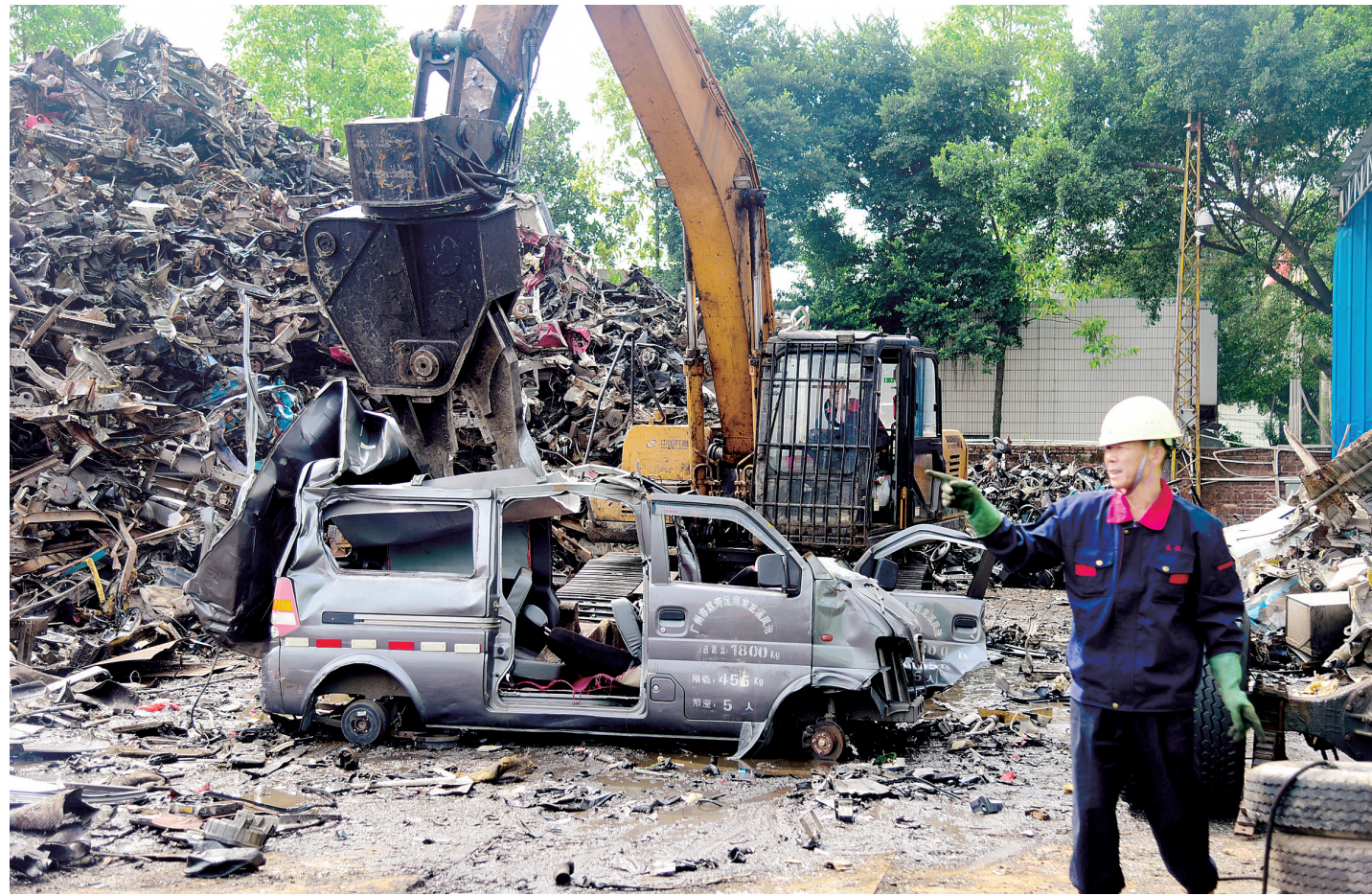
广州市金属回收有限公司购销部工人使用机械拆解报废汽车(4月17日摄)
