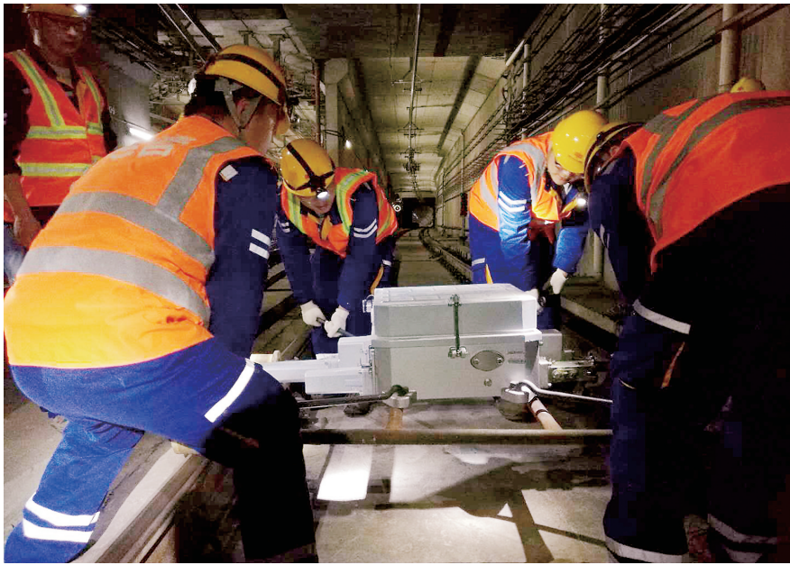
一台控制列车方向的转辙机需要4个人抬
