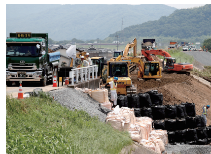
工人修复受损的河堤
