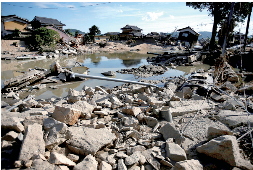
日本冈山县仓敷市真备町被毁坏的房屋
