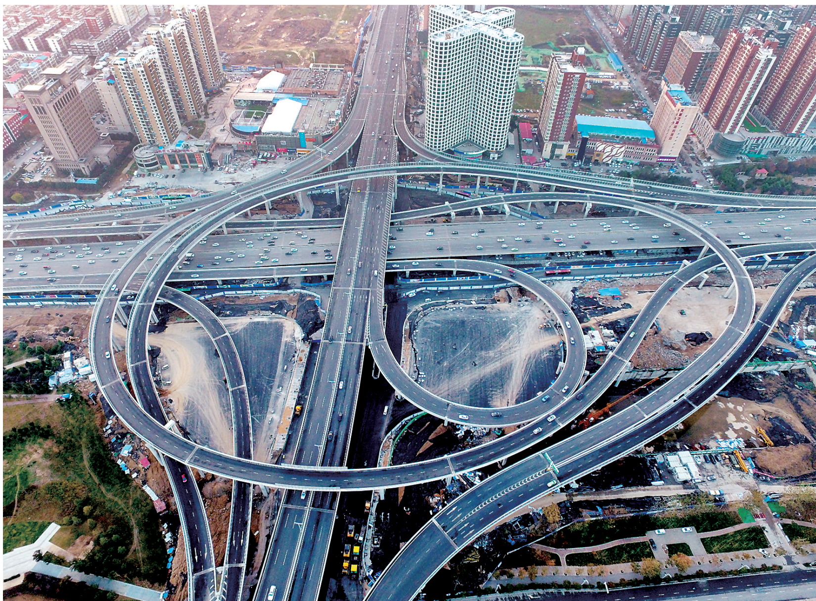
中州大道农业路立交桥 记者 周甬 图
