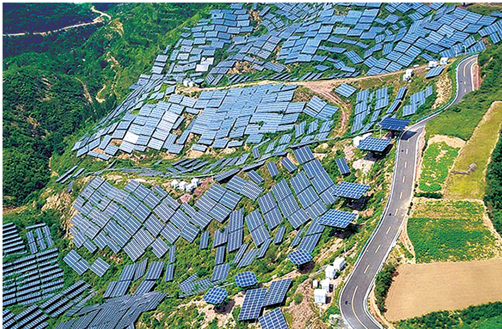
荒山上布满了光伏发电站
